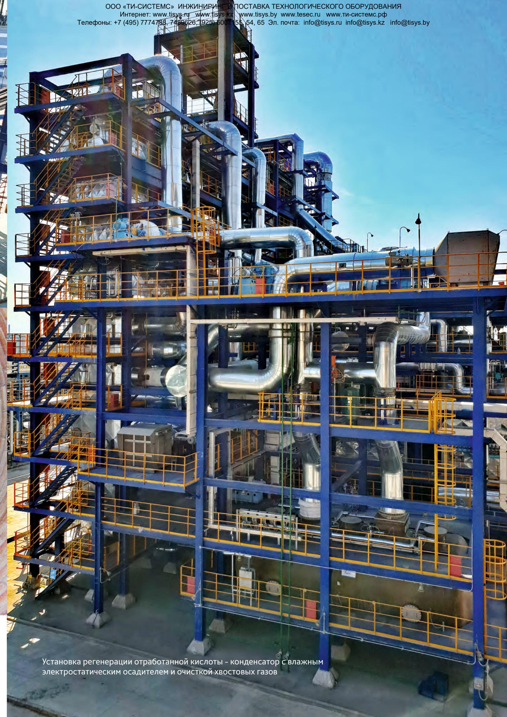
Установка регенерации отработанной кислоты - конденсатор с влажным электростатическим осадителем и очисткой хвостовых газов
